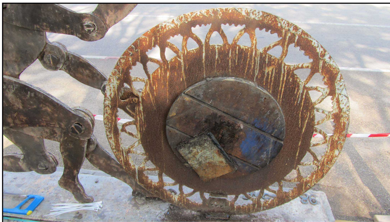
בין שני חלקי הופן נמצאה פלטת העץ במצב של ריקבון, בנוסף זבל שנדחף ביניהם, פלטת העץ הוחלפה בעץ בירץ' המתאים לתנאי מזג אוויר חיצוני מטופל בחומר דוחה גשם
