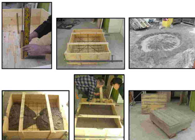
Costruzione del basamento
