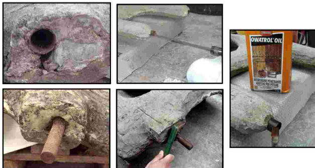
pulitura e trattamento dei perni in ferro
